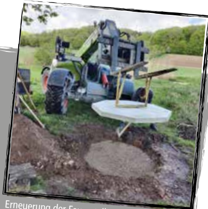
Erneuerung der Feuerstellen am Silbersee
